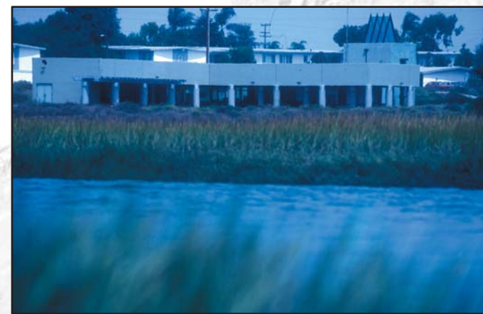
Visitor's Center 3 Centro de Visitantes
